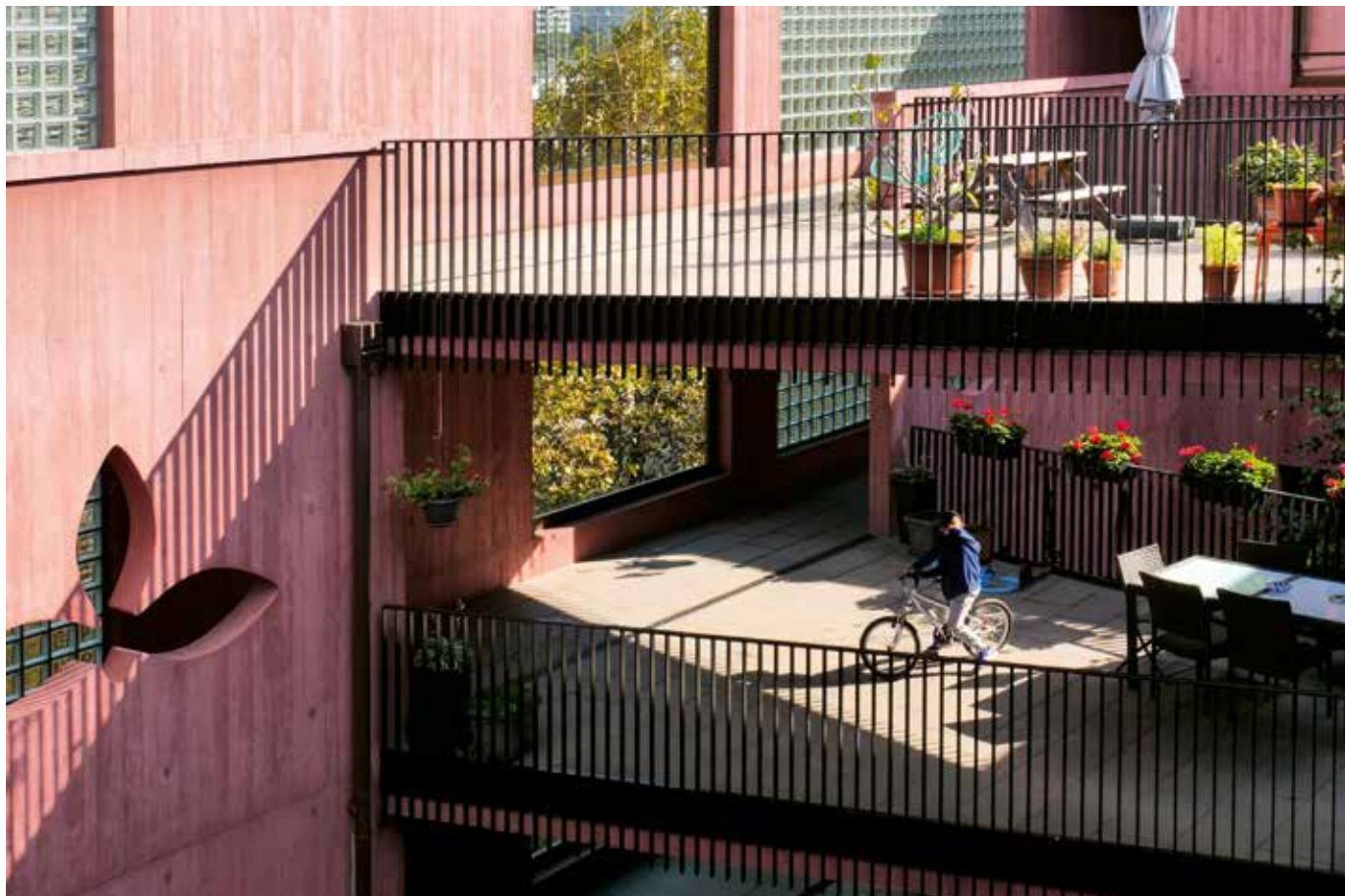
Les galeries d'accès aux appartements, végétalisées et sculpturales, sont utilisées quotidiennement par les habitants comme extension de leur logement, mais aussi comme lieu de rencontre entre les familles et espace de jeux pour les enfants. Ces espaces d'articulation entre les entrées des logements, les circulations du bâtiment et la cour intérieure créent une zone tampon qui protège des nuisances sonores de la route, tout en respectant l'incidence de la lumière. Les qualités spatiales sont telles que le parcours architectural au sein de l'ensemble bâti devient une expérience forte pour l'usager. Erlenmatt Ost, logement social (Fondation Habitat), Galli Rudolf Architekten, Bâle, Suisse, 2017.
